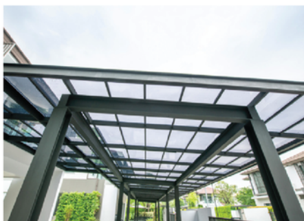
Mái sảnh, mái nhà để xe
