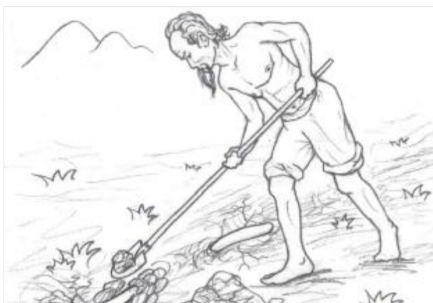
Hình 22: Bảo d-ỡng đ-ờng ống, lấp đất những chỗ đ-ờng ống bị hở.
