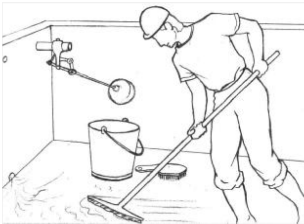
Hình 18: Cọ rửa bể chứa nước sạch.
