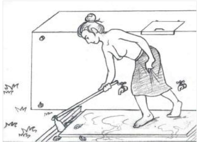
Hình 17: Khơi thông thoát nước, bảo dưỡng xung quanh bể sử dụng.
