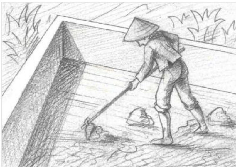
Hình 7: Kiểm tra thau rửa bể lọc chậm
