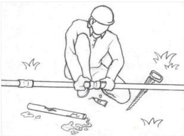
Hình 26: Nối ống PVC khi có phụ kiện.
